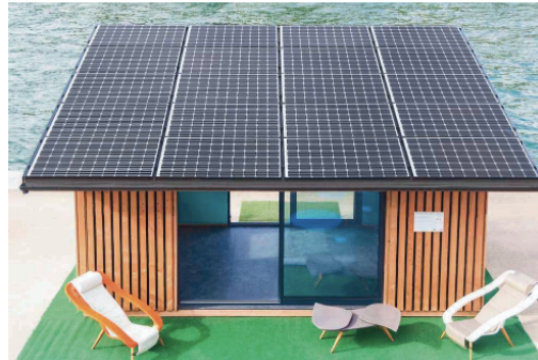
Figure 1. Panneaux photovoltaïques sur un toit plat
